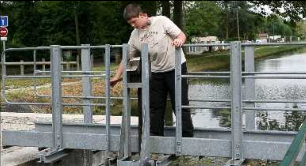
Il faut manoeuvrer la vantelle de la porte amont pour remplir le sas.
