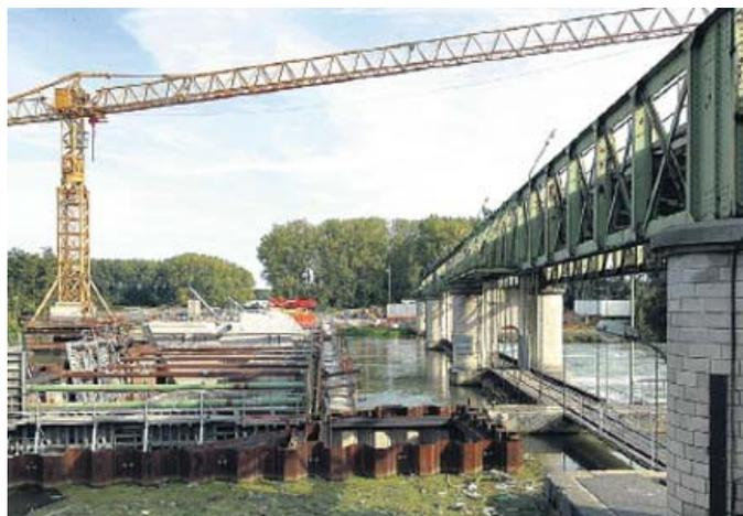
VERBERIE, VENDREDI, BARRAGE SUR L'OISE. Le chantier de modernisation du barrage progresse au rythme de l'assèchement partiel de l'Oise par endroits, afin de permettre la construction d'un édifice moderne. (LP/ARNAUD DUMONTIER.)
