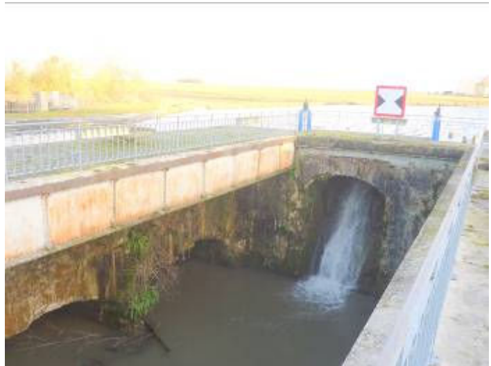
Pont-canal de Noyelles-sur-Escaut
