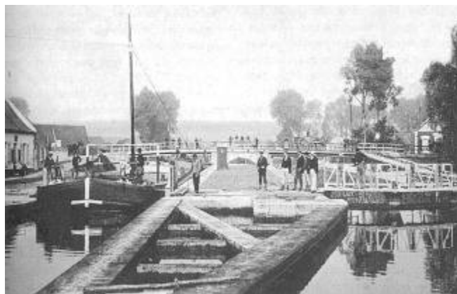
Ecluse à double sas à Honnecourt-sur-Escaut collection particulière
